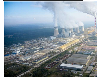
une centrale thermique (a)
